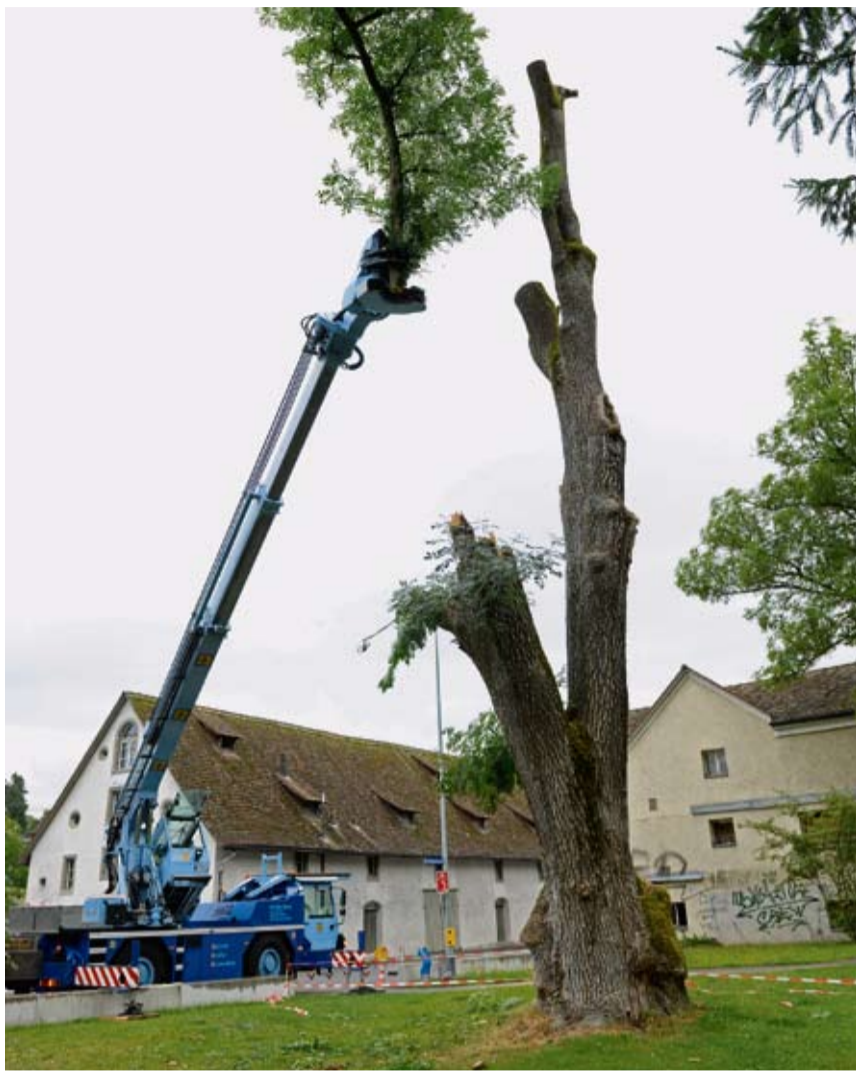
Das Fällmobil entfernt den letzten Teil der Baumkrone.
