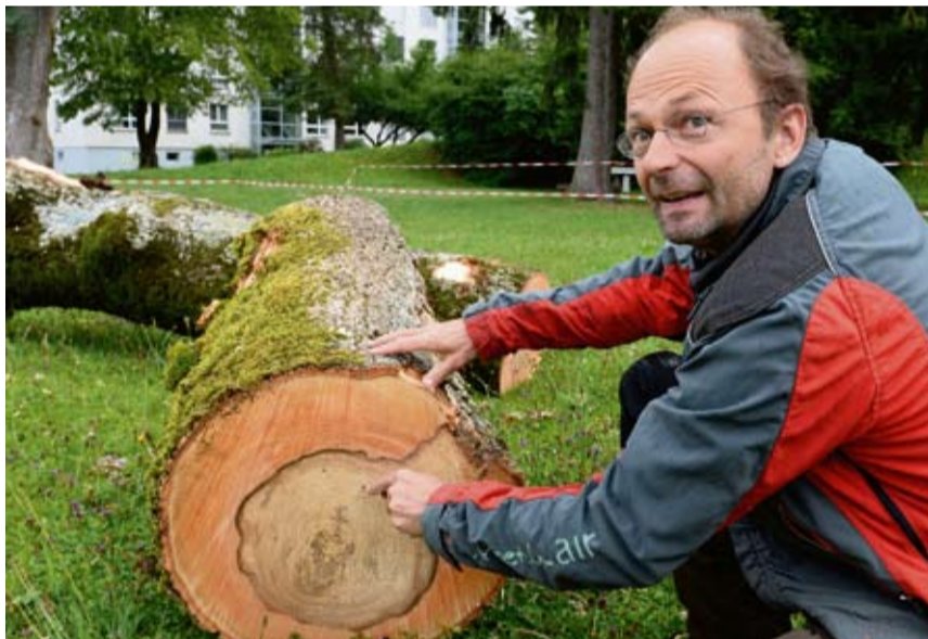
«Das Holz verliert die Stützkraft»: Baumpfleagespezialist Hansueli Meyer zeigt den Fäulnisbereich im Inneren des Baumstamms, der teilweise schon bis zur Rinde reicht.
